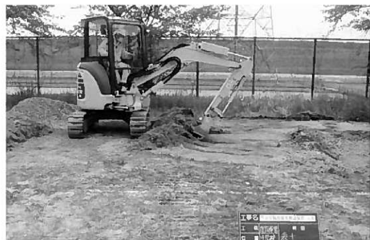
除染作業当時の様子
