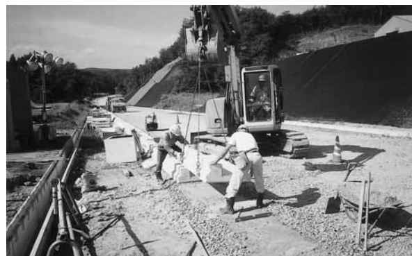
▲18年度に完成した町道髷石線
