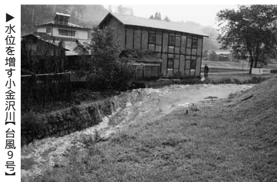
崩壊した水田ののり面【台風9号】
