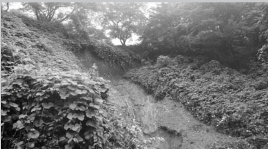
法面が崩落した大沢地内
