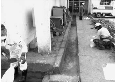
除染作業の様子
