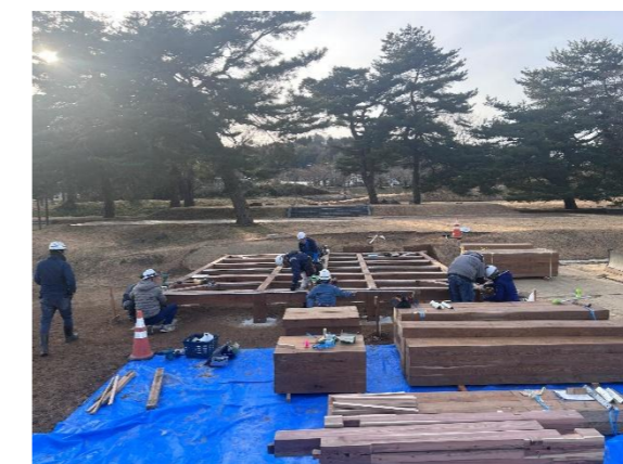
⑤搬入した材料を組み立てる
