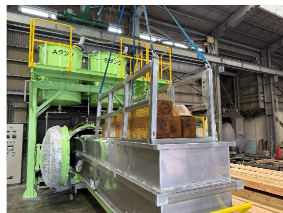
防腐処理の様子(奥の窯で薬剤を浸透させる)
