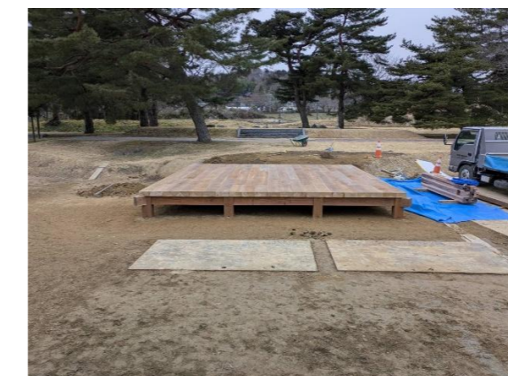
⑦床板張り完了
