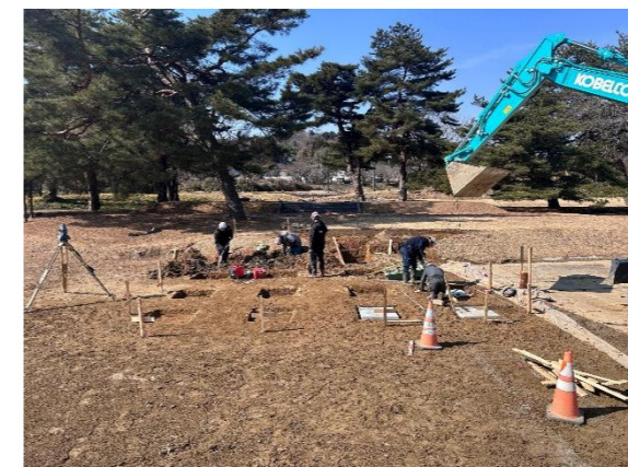
③70cm四方のコンクリートブロックを設置
