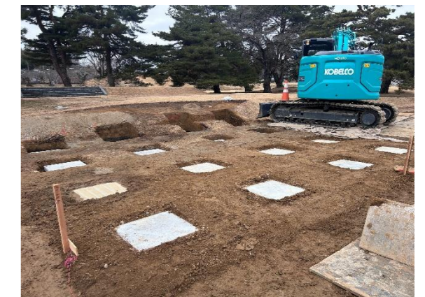
④設置完了
