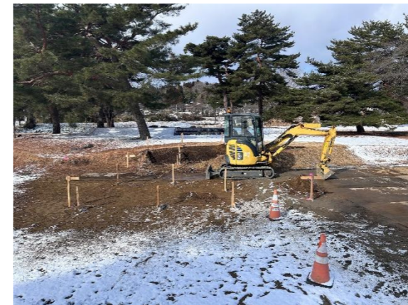
①基礎を据えるための掘削開始
