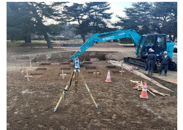
②基礎を設置する16か所の穴を掘る
