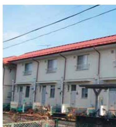
水洗化工事が進む高田前団地
